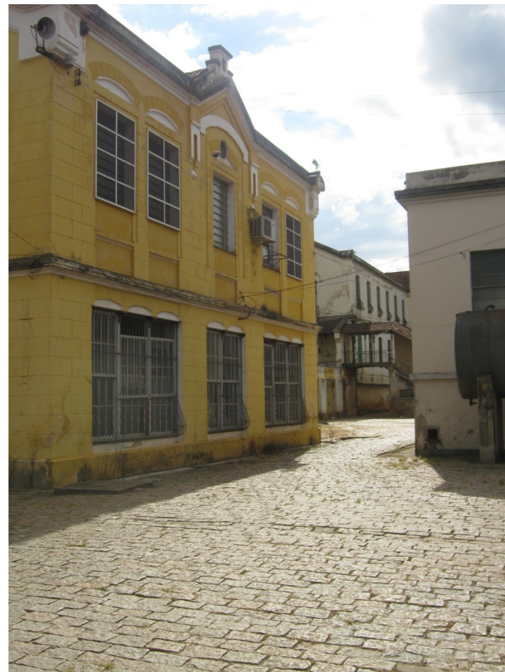
Figura 30. Área interna do complexo. Fonte: Arquivo pessoal.
