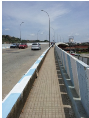
Figura 4. Passeio público sobre o viaduto. Fonte: Arquivo pessoal.
