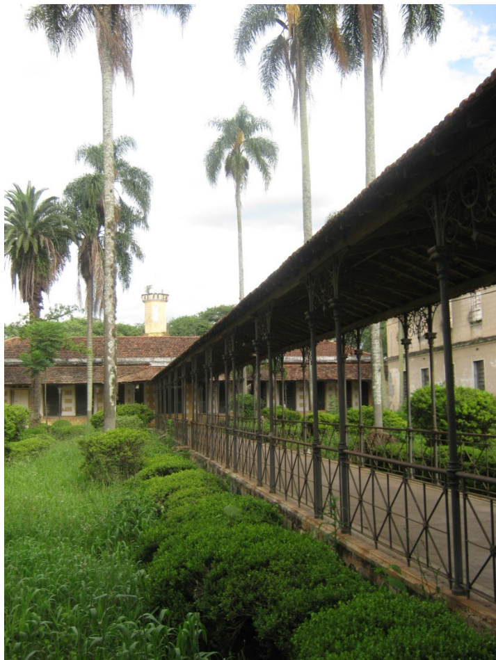
Figura 29. Área interna do complexo. Fonte: Arquivo pessoal.
