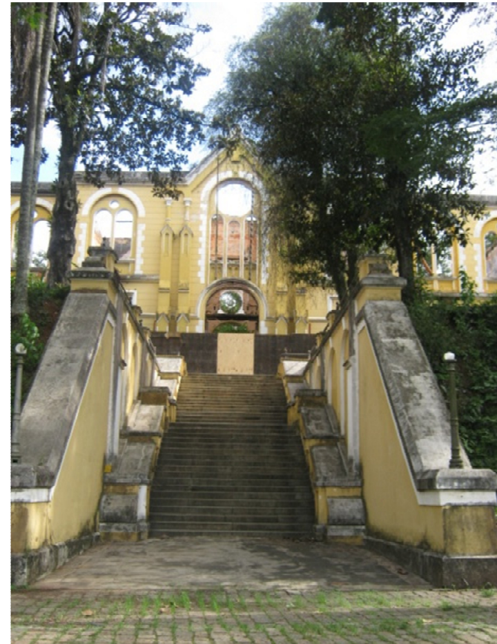
Figura 28. Antigo prédio da administração após o incêndio.
