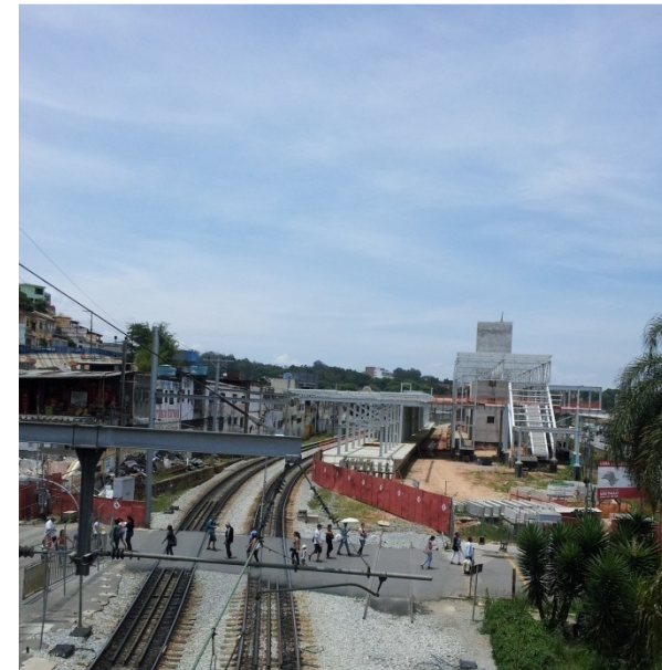
Figura 24. Nova Estação de Trens da CPTM em obras. Fonte: Arquivo pessoal.
