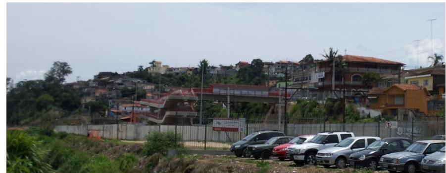
Figura 47. Nova passarela ligando o bairro Jardim Progresso ao centro. Fonte: Arquivo pessoal.
