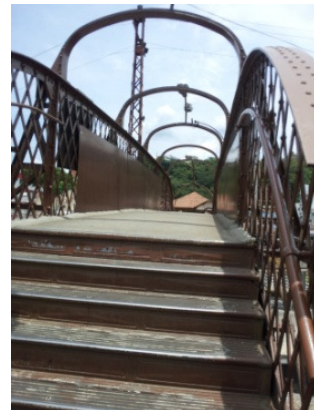
Figura 5. Passarela sobre o trem. Fonte: Arquivo pessoal.
